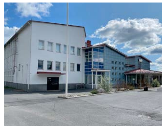
Kuortaneen yhteiskoulun vesikatteessa on havaittu ongelmia, joten kattoa joudutaan uusimaan tänä vuonna.
